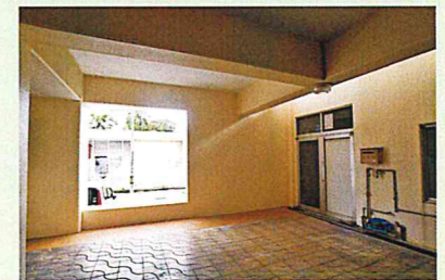
1階新設耐力壁
